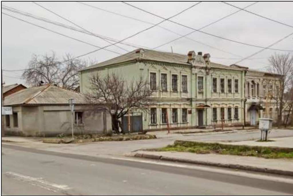
Вид зданий бывшего училища и гимназии (ул. Горького № 9 и 7) на 6 января 2024 г.
